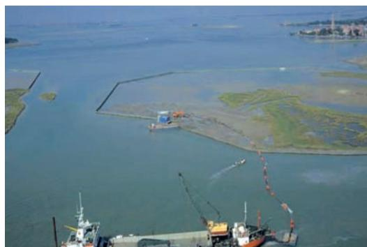
**Figura 5:** realizzazione di strutture morfologiche artificiali. **STADIO 0:** refluentamento di miscela di sedimento e acqua entro conterminazioni. Già nella prima fase di realizzazione si creano aree favorevoli all'alimentazione e alla nidificazione dell'avifauna.
