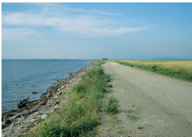
**Figura 6: visione della sponda sud. L'argine sul quale scorre la strada fu innalzato dalle opere di bonifica per impedire l'allagamento dei terreni confinanti.**
