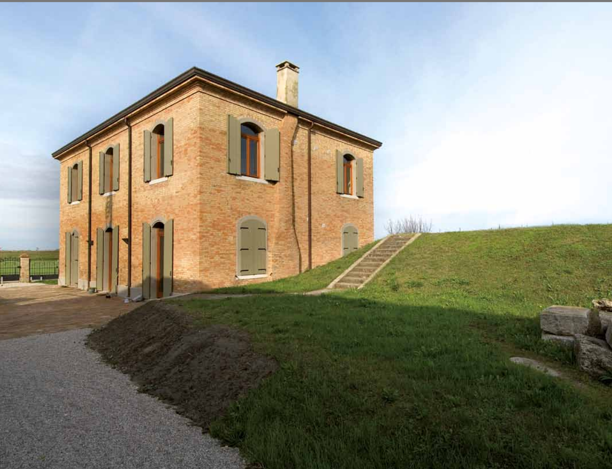
TAVOLA 3a. Casa di abitazione degli idrovoristi annessa all'impianto idrovoro Sadocca, oggi adibita al turismo tematico
