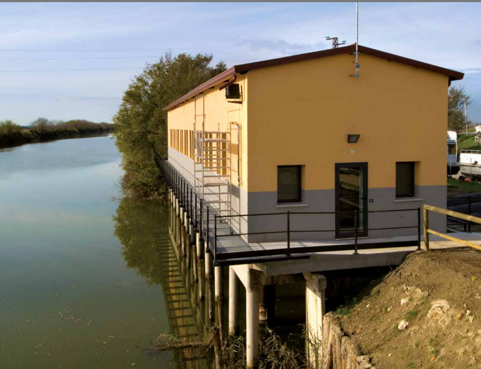
TAVOLA 2a. Vista sud-est dell'ex idrovora Emissaria ristrutturata. A fianco il Collettore Padano Polesano
