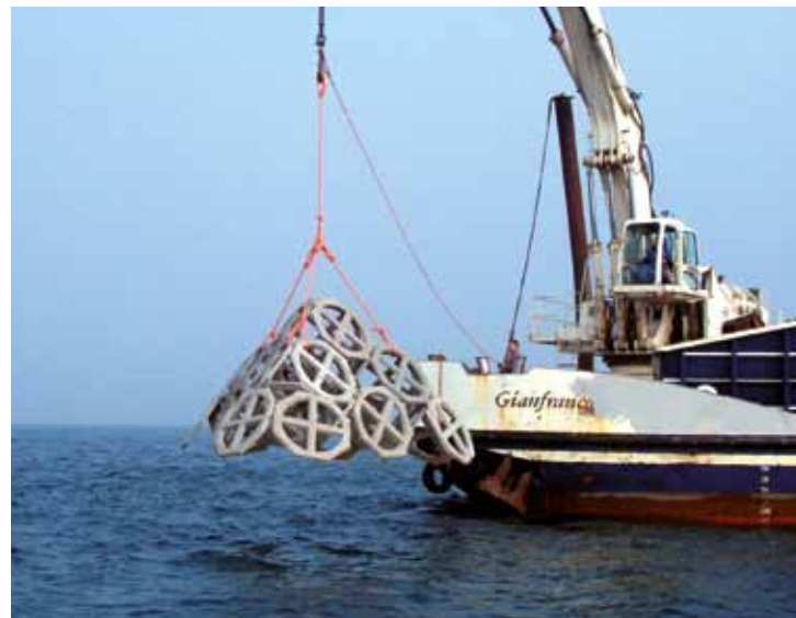
6. Posa in opera di barriere artificiali
