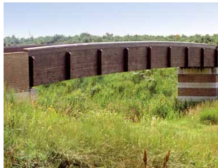
4. Passerella di accesso all'Oasi di Ca' Mello attraversante il canale Principale Valli
