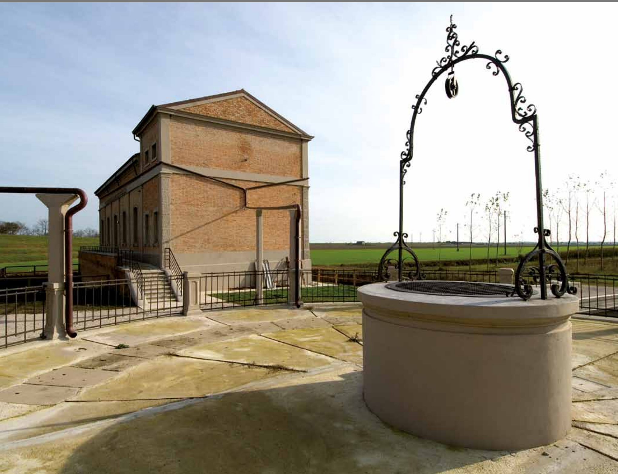
TAVOLA 5a. Vista ovest dell'ex Idrovora Ca' Giustinian ristrutturata, in primo piano la cisterna per la raccolta dell'acqua piovana
