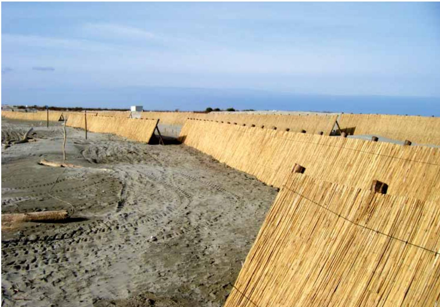
**37c** Piantumazione specie alofile per stabilizzazione scanno; i graticci di canna facilitano l'attecchimento
