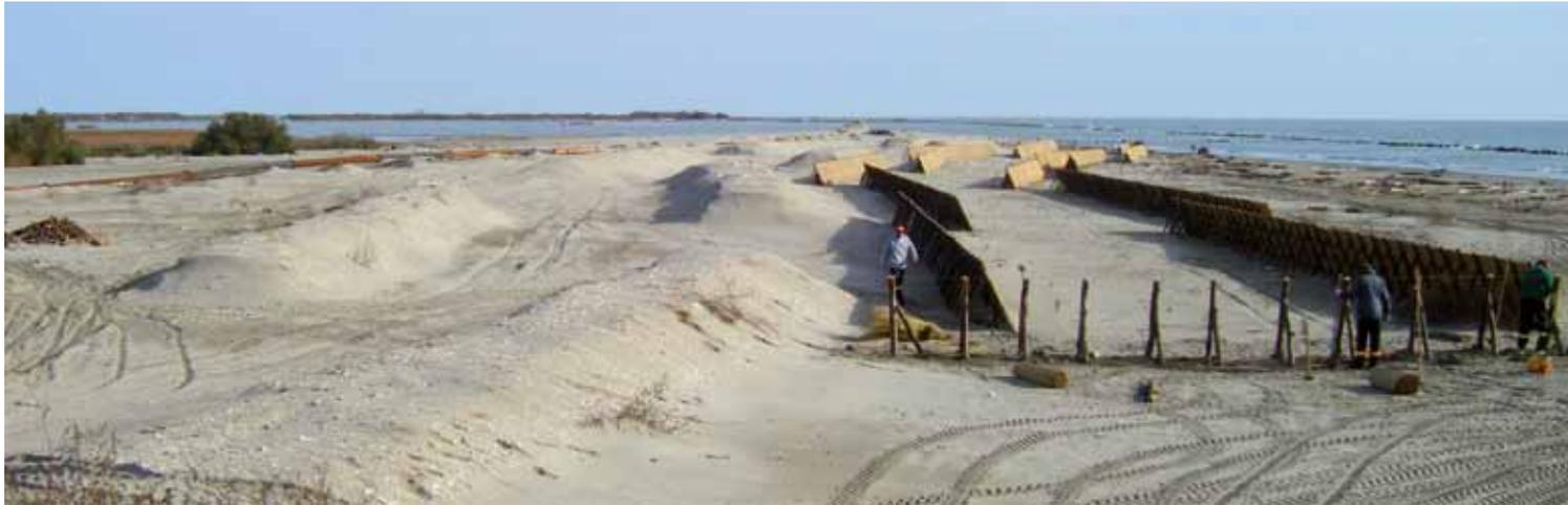
**37b.** Piantumazione specie alofile per stabilizzazione scanno; i graticci di canna facilitano l'attecchimento
