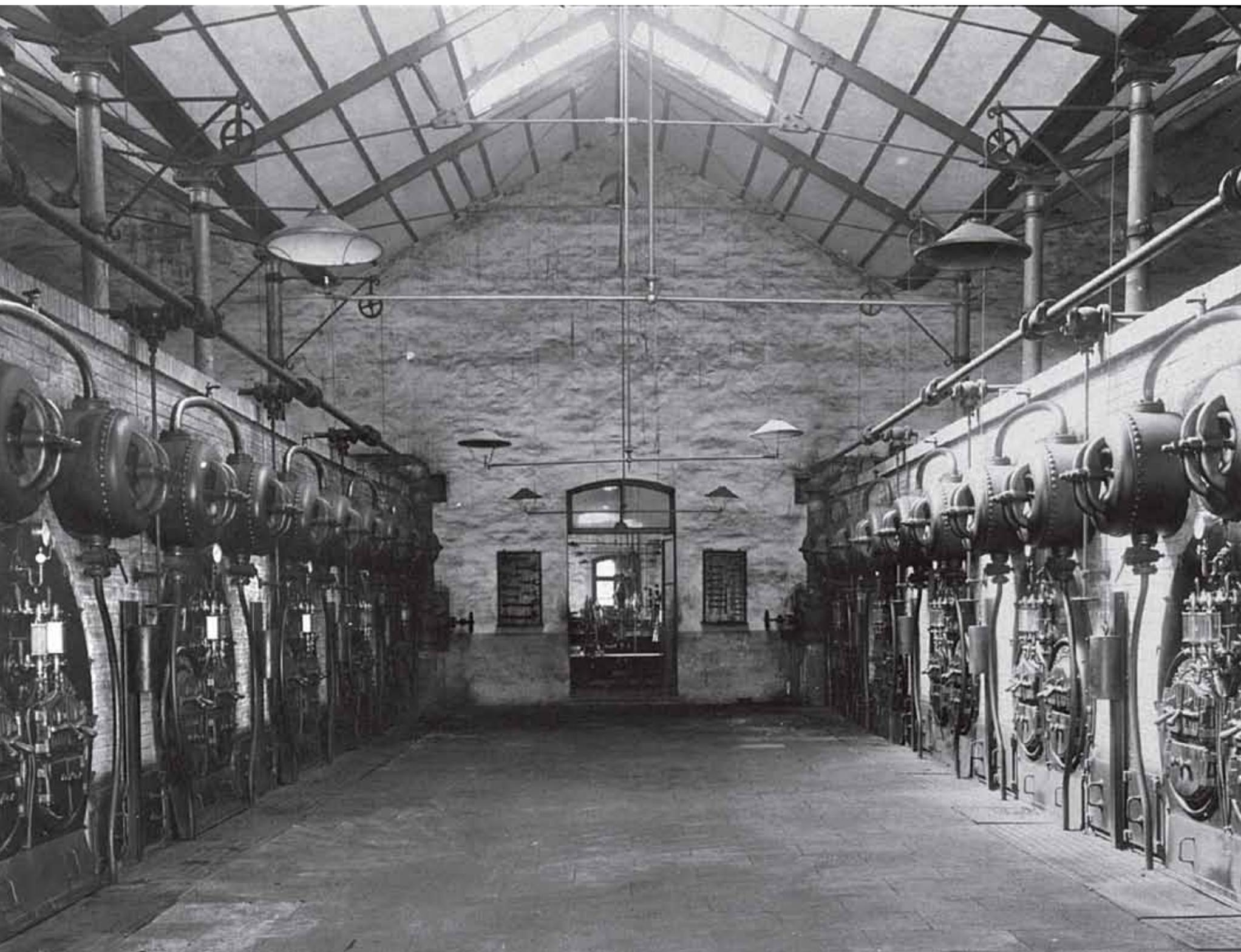
La prima coppia di pompe aveva una portata di 2.000 l/s e la seconda di 3.500 l/s cadauna per una portata complessiva di 11.000 l/s.
